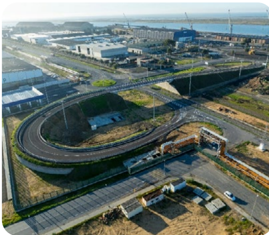
Obra del acceso único.
