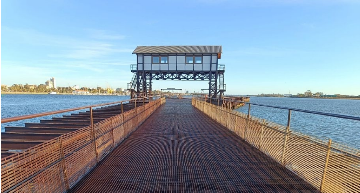
Rehabilitación Muelle de Tharsis (finalización de las obras)
