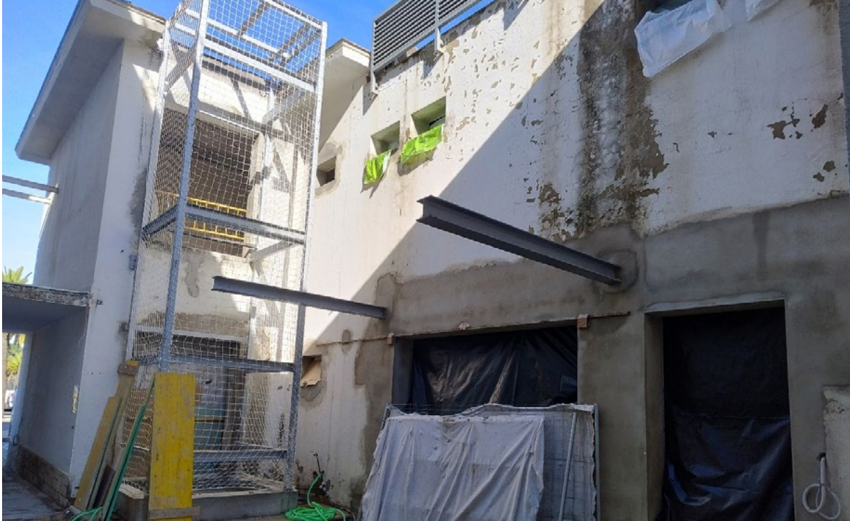
Habilitación del edificio Estihuelva (durante las obras).
