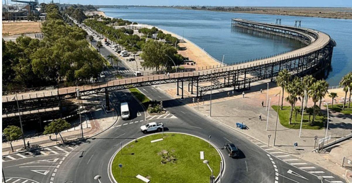
Unión Muelle Riotinto (finalización de las obras).
