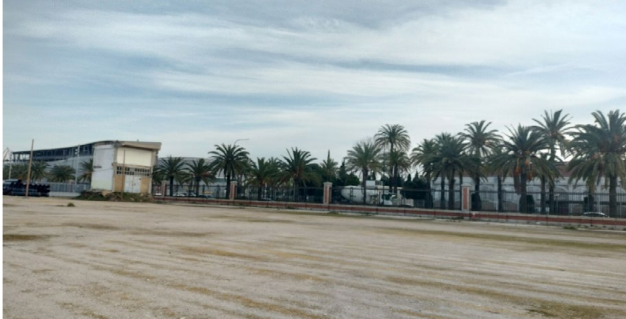
Demolición del último módulo (durante las obras).
