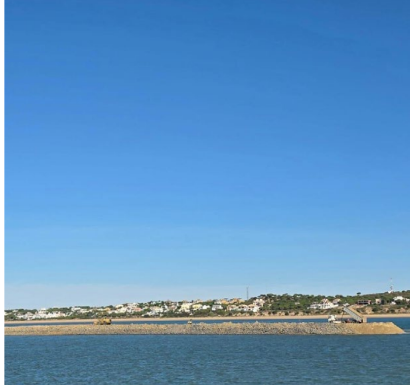
Recinto nº4 Fase 2 (durante las obras)
