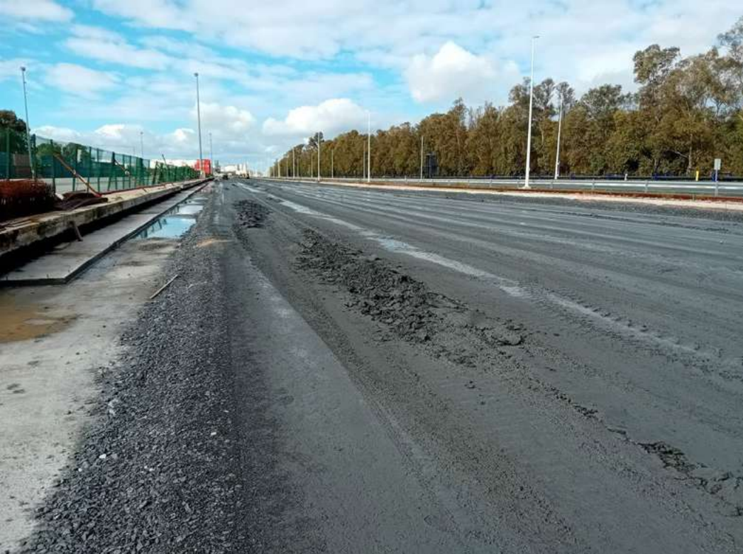
Ampliación de la terminal ferroviaria (durante las obras).
