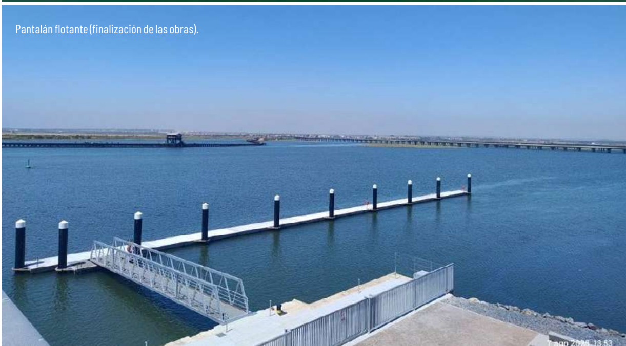
Nueva plataforma Ro-Ro (finalización de las obras).
