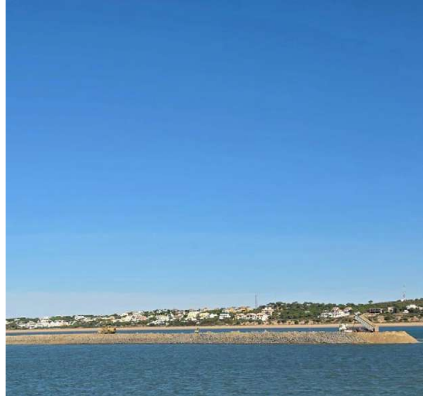
Recinto nº4 Fase 2 (durante las obras)
