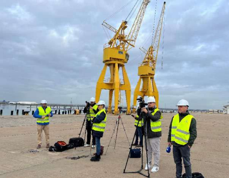
Medios de comunicación en el Muelle de Levante con motivo del derribo de las antiguas naves de Expofrisa.
